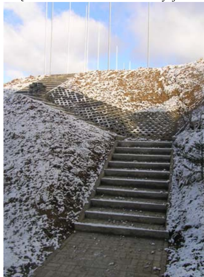
Schody terenowe stanowiące główny ciąg komunikacyjny między szkołą a płytą boiska
