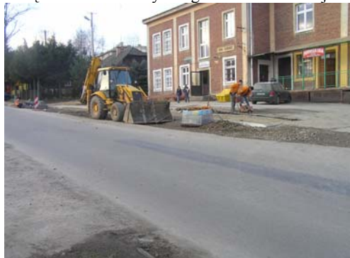
Przebudowywana zatoka przy Domu Ludowym w Chmielniku
