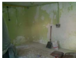
Siłownia przed remontem
