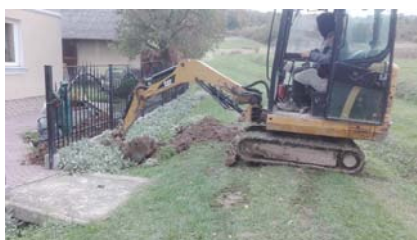
Budowa sieci wodociągowej
