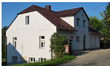
Budynek Domu Ludowego w Woli Rafałowskiej
