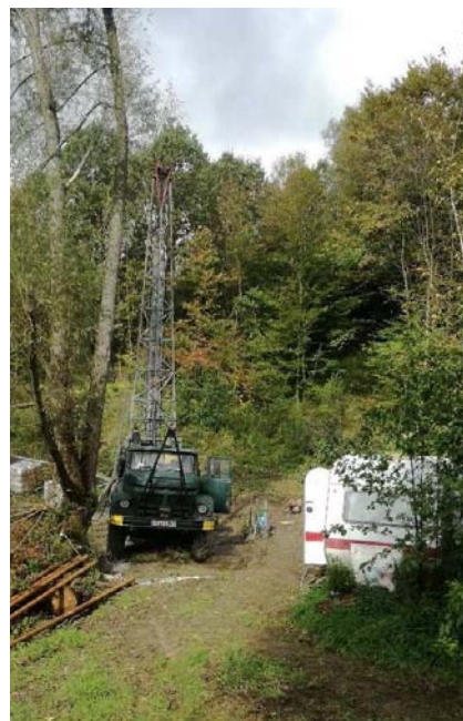
Budowa studni S-6 w Chmielniku
