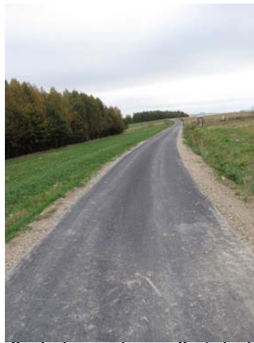
Przebudowana droga w Borówkach
