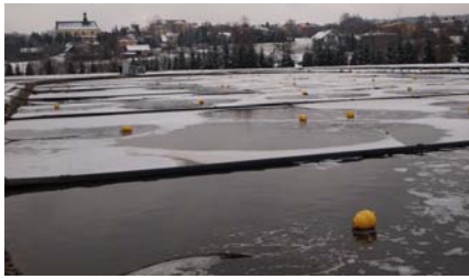
Rozbudowa Oczyszczalnia ścieków
