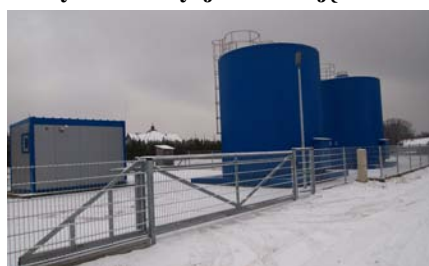
Zbiorniki retencyjne i hydrofornia Chmielnik - Wielkopolska
