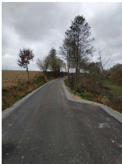
Przebudowa drogi na dz. o nr ewid. 751 Zabratówka Wieś – Zabratówka Kłapy w km 0+000 – 0+670 wraz z przebudową przepustu w km 0+312 w miejscowości Zabratówka
