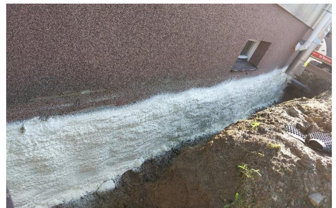
Ława fundamentowa po renowacji i wykonaniu natrysku ciśnieniowego pianą PUR.
